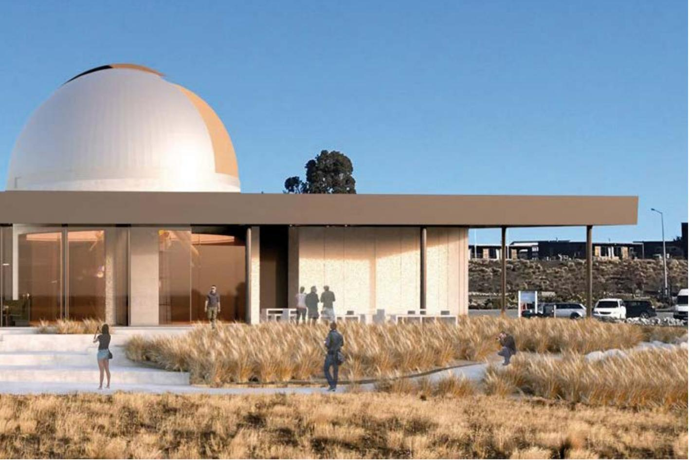
将固瑞特的防火PET 结构泡沫与固瑞特的防火Ampreg™环氧层压系统相结合，完成了圆顶的建造。这种环氧树脂对于实现良好的热稳定性和避免固化变形至关重要，可实现各部分的无缝组装。圆顶只用三个主要模具制造：一个用于3米×7米的弯曲部分，一个用于百叶窗板，一个用于基础环防水板。圆顶在工厂完全组装好，然后分成两半，运输到施工现场，使用起重机抬升和安装之前重新组装好。
