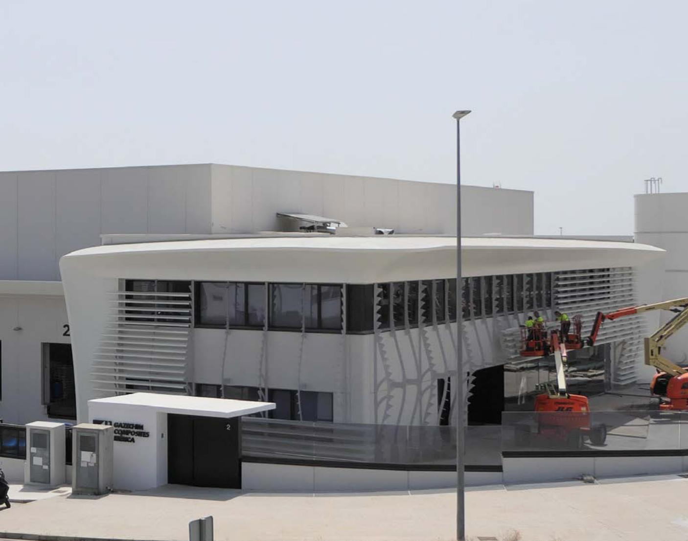
无碱玻璃做衬里，然后再用 Kerdyn™ Green FR 覆盖。然后使用真空辅助树脂浸渍来拉动树脂通过并浸渍面板。Graphenano Composites还将石墨烯纳米技术纳入到所选的聚酯树脂中，这在重量、强度和耐用性方面展现了进一步的结构优势。
